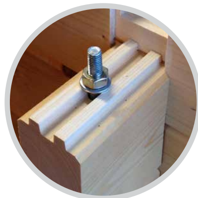
Drilled in threaded rod for wind safety Eingeborte Gewindestange En las esquinas varillas de rosca Barras de Refuerzo (Parafusos Sem Cabeça) Tiges filetes anti-tempete Barra filettata per foratura Draadeinden in de wand verwerkt Засверленная резьбовая шпилька для ветрозащиты Rüzgara karşı güvenlik için dişli çubuk üzerine delme
